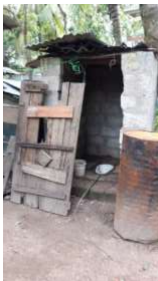
het oude toilet
